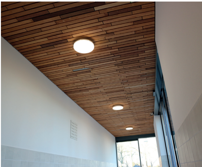
Foto: Plafondplaten gemaakt van sloophout uit het eigen project.
