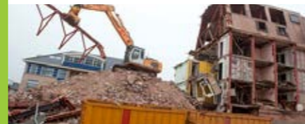
sloop en recycling
